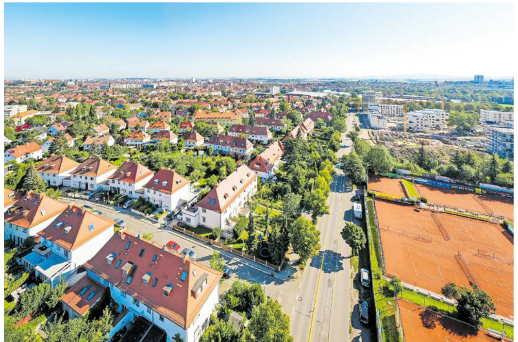
Der Baubeginn in der Martin-Andersen-Nexö-Straße/Arnstädter Chaussee ist für Oktober 2025 geplant.
