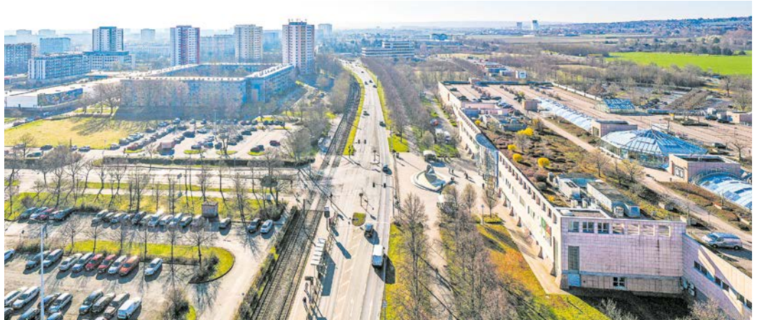
Noch in diesem Monat beginnt die Sanierung der Nordhäuser Straße zwischen Moskauer Straße und Warschauer Straße.
