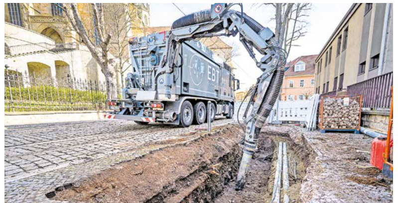
Ein Saugbagger arbeitet nicht nur präzise und schnell, sondern produziert auch vergleichsweise wenig Lärm und Staub.
