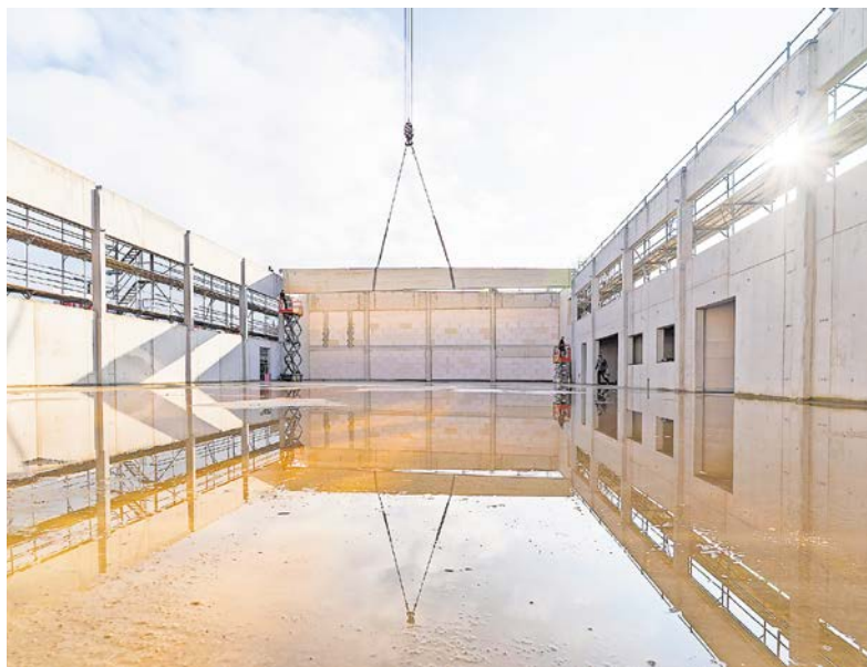
Ende Februar wurden die Dachbinder für die neue Schulsporthalle im Muldenweg eingehoben.
