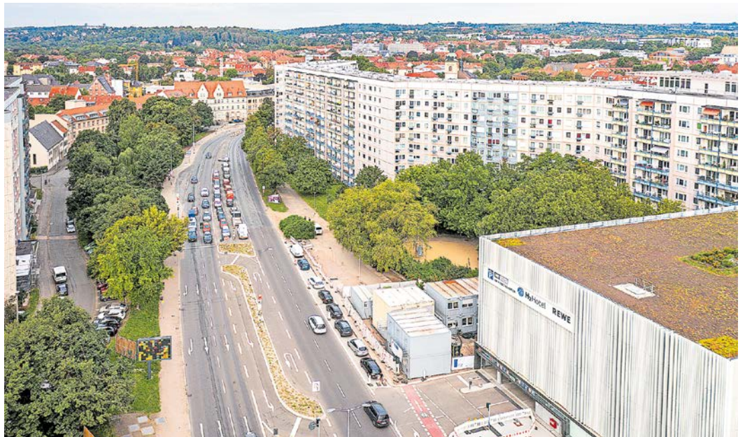
Der Radweg führt nach den Bauarbeiten bis zum Karl-Marx-Platz
