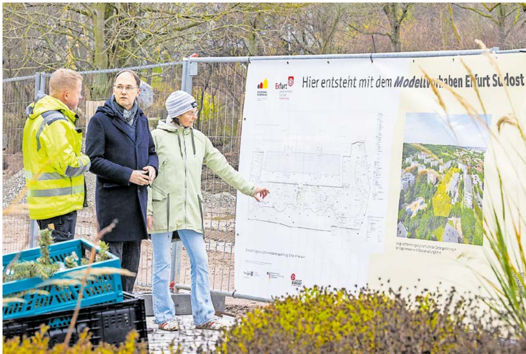
Planerin Andrea Wenzel-Schlicht und Bauleiter Silvio Kords erläutern dem Beigeordneten Dr. Tobias J. Knoblich die Planung.
