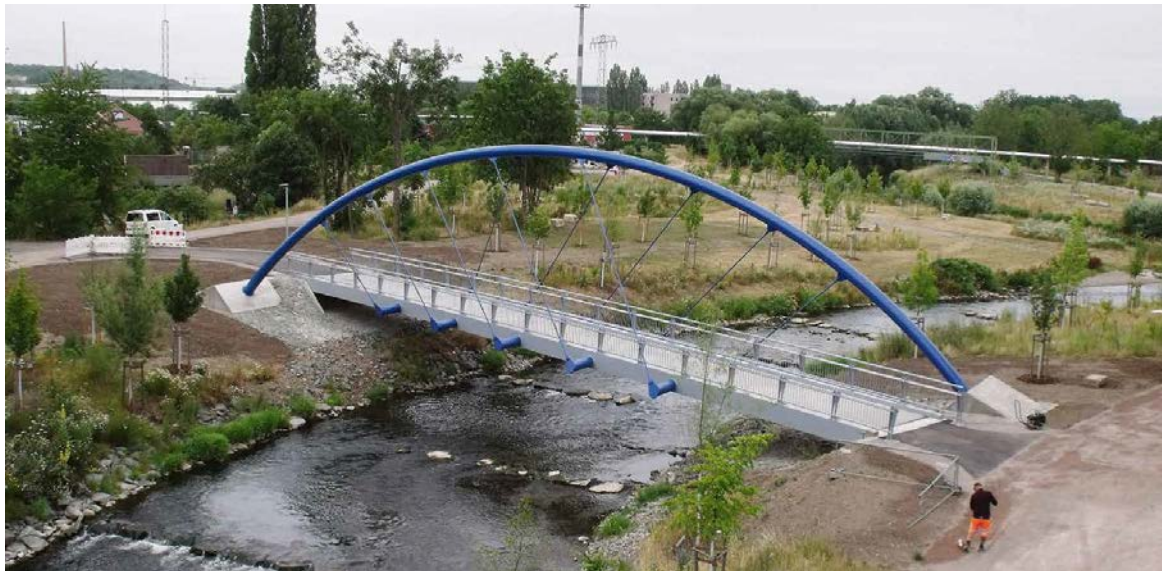
Die Fußgänger- und Radwegbrücke Geraflosschleife in Gispersleben ist freigegeben.
