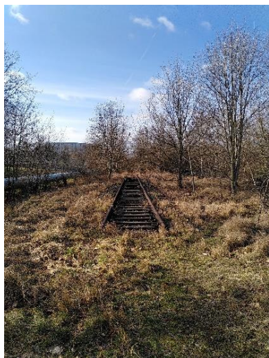
in Richtung Westen Trassenfragment
