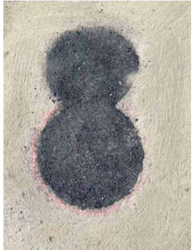
Abb. 8: Verschluss der Aufschachtung mit Kaltasphalt
