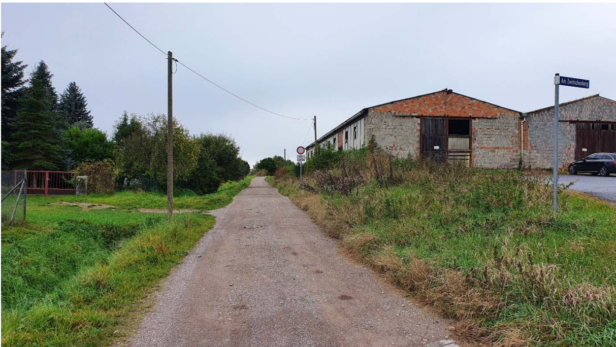
Bild 4 Mückenborn (links), Hallen und asphaltierte Hallenvorfläche (rechts mittig)
