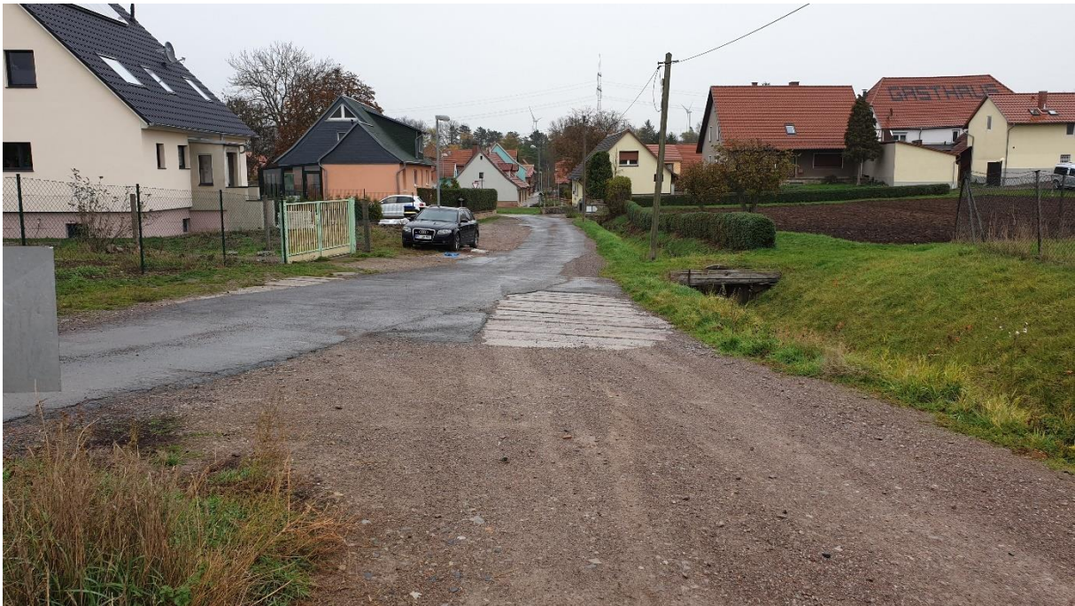
Abbildung 10 Zufahrt, Straße Am Zwetschenberg Foto: G. Weber 08.11.2019
