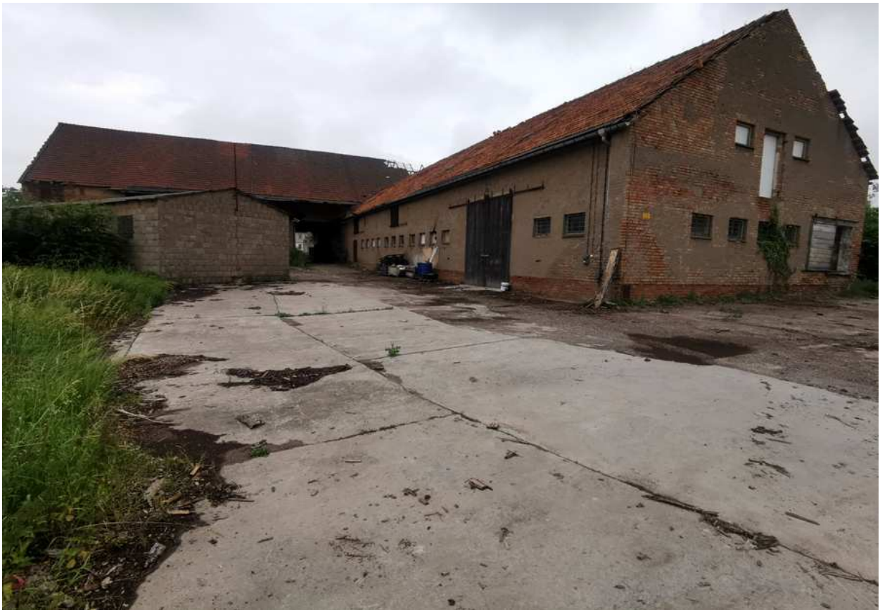
Abb. 5 vollversiegelte Flächen (Gebäude und Verkehrsflächen) mit Blick in Richtung Süden
