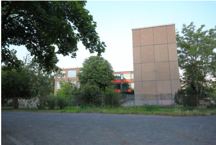
Abb. 15: Ostfassade der Grundschule
