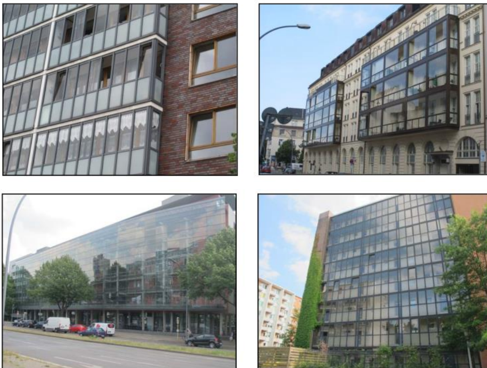
Abbildung 3: Beispiele für teilgeöffnete Außenbauteile zum Schutz gegenüber Verkehrslärm (oben: geschlossene Vorbauten, unten links: Vorhangfassade, unten rechts: Laubengänge)
