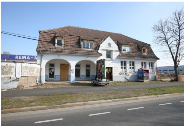
Abb. 12: Gebäude 8. Ehemalige Verkaufsstelle
