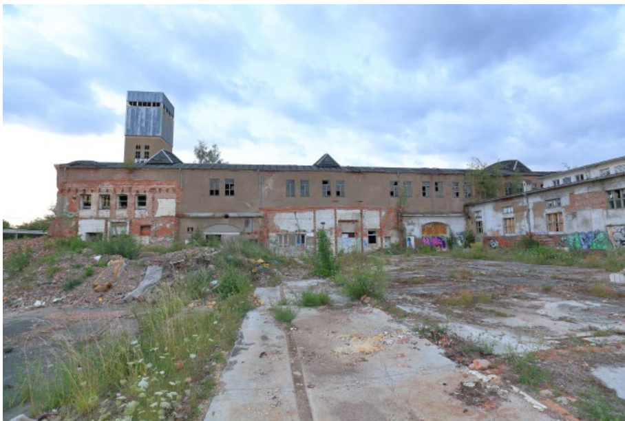
Abb. 26: Gebäude 6. Ansicht von Nordwesten
