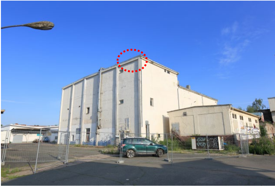
Abb. 19: Gebäude 6 c. Ansicht von Südost
