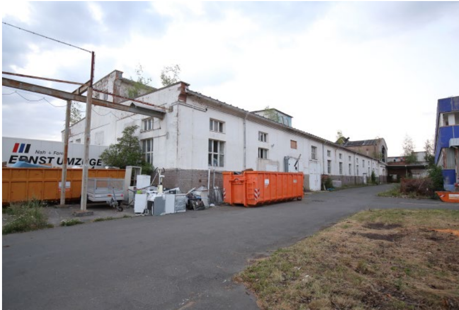
Abb. 17: Gebäude 6 a. Ansicht von Nordwest
