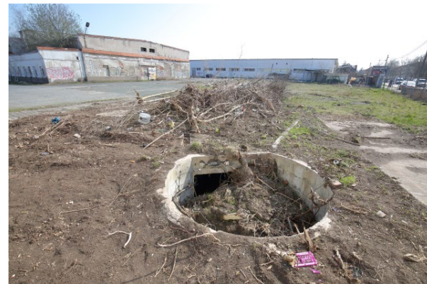
Abb. 13: Zugang zu unterirdischen Versorgungsstollen
