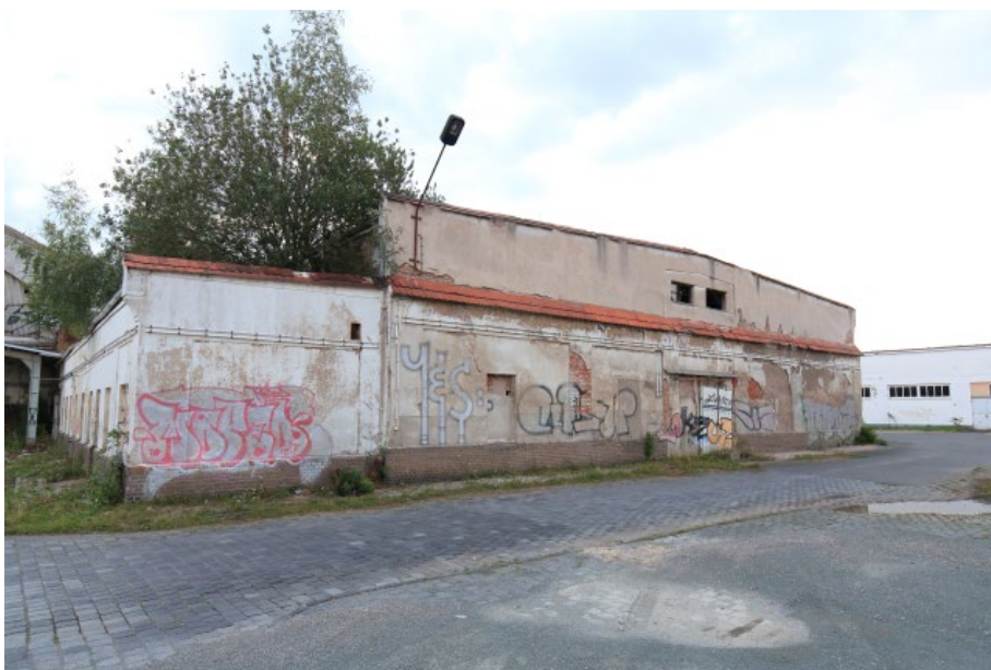
Abb. 18: Gebäude 6 e. Ansicht von Westen
