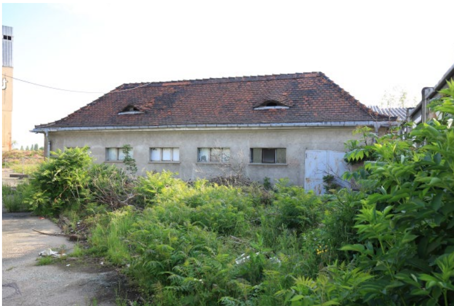
Abb. 22: Gebäude 11. Ansicht von Süden
