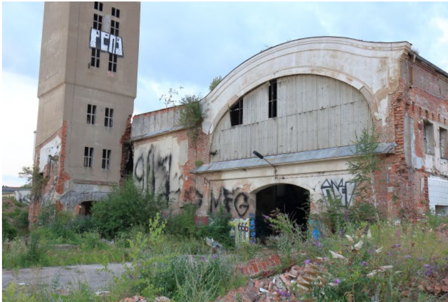
Abb. 25: Gebäude 6. Ansicht von Nordost
