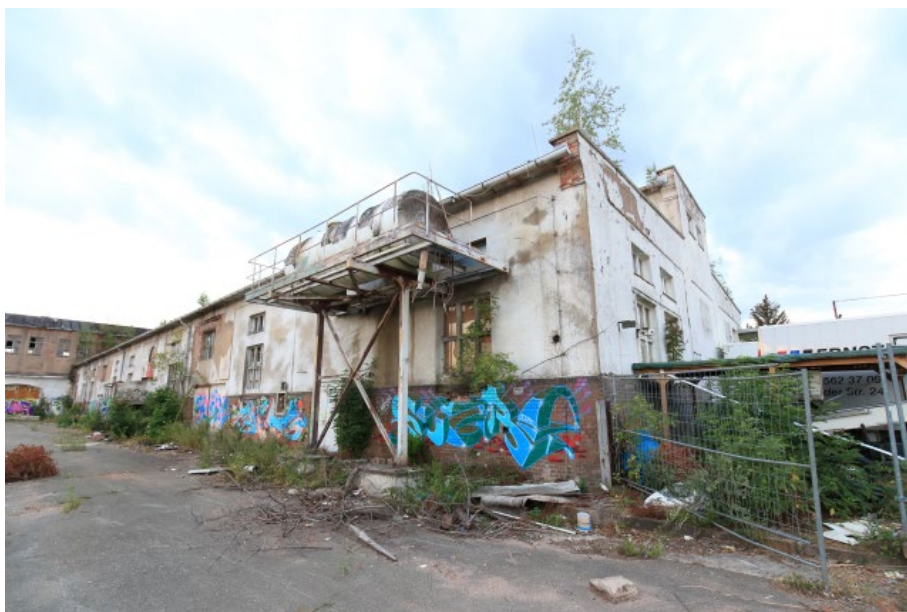
Abb. 16: Gebäude 6 a. Ansicht von Norden
