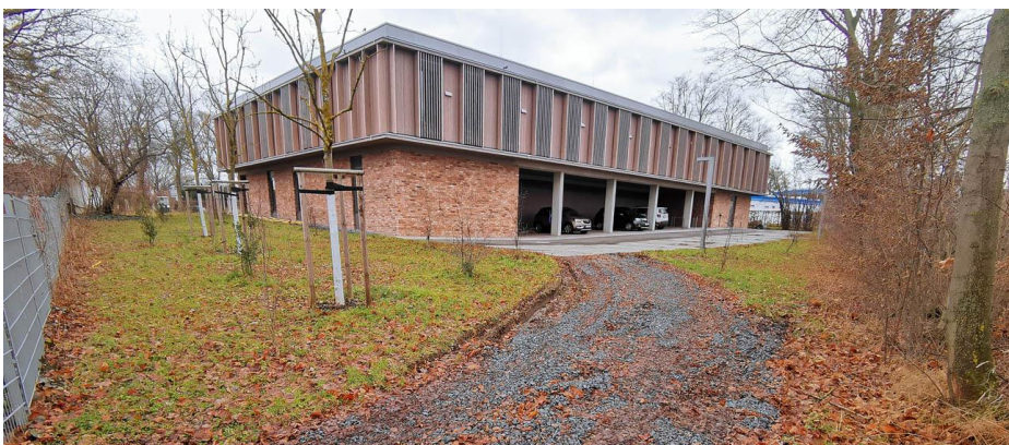
Abb.: Neubau des Naturschutzzentrums aus Blickrichtung Norden; Bild: quaas-stadtplaner
