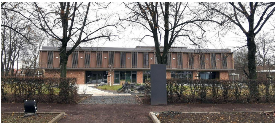
Abb.: Neubau des Naturschutzzentrums aus Blickrichtung Osten /ega; Bild: quaas-stadtplaner
